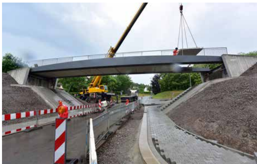
Foto: Keren GmbH, Brücke Haisbachstraße/Kusel
