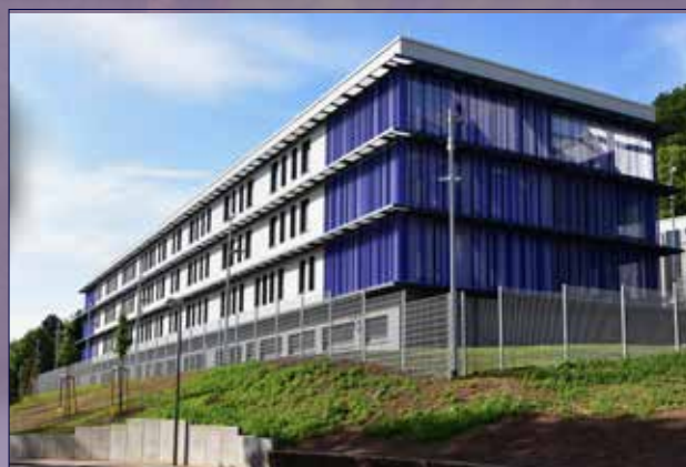
Merzig SKFP Foto: Peter Keren Bauunternehmung GmbH
