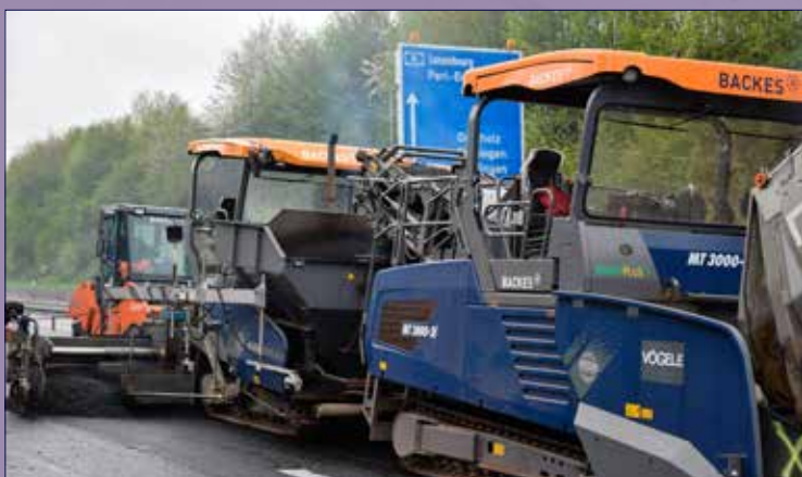
Bauvorhaben A8 Richtung Luxemburg Foto: Backes AG & Co. KG
