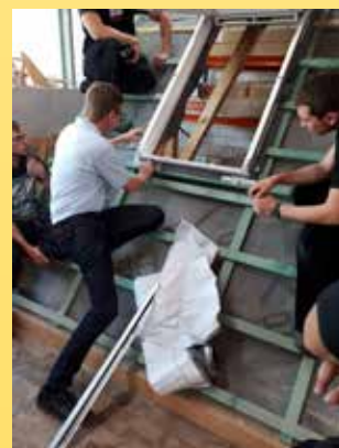
Velux Schulung für Zimmerer Azubis - Einbau von Dachfenstern 05.06.
