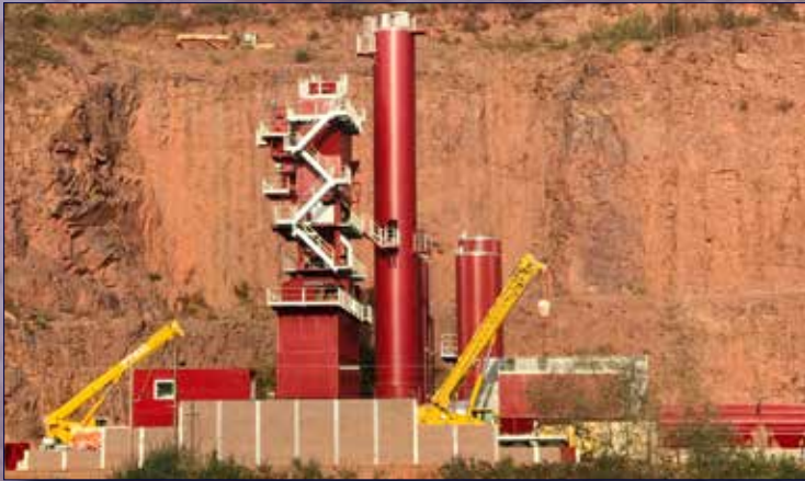
Taben AMAT Foto: Peter Keren Bauunternehmung GmbH
