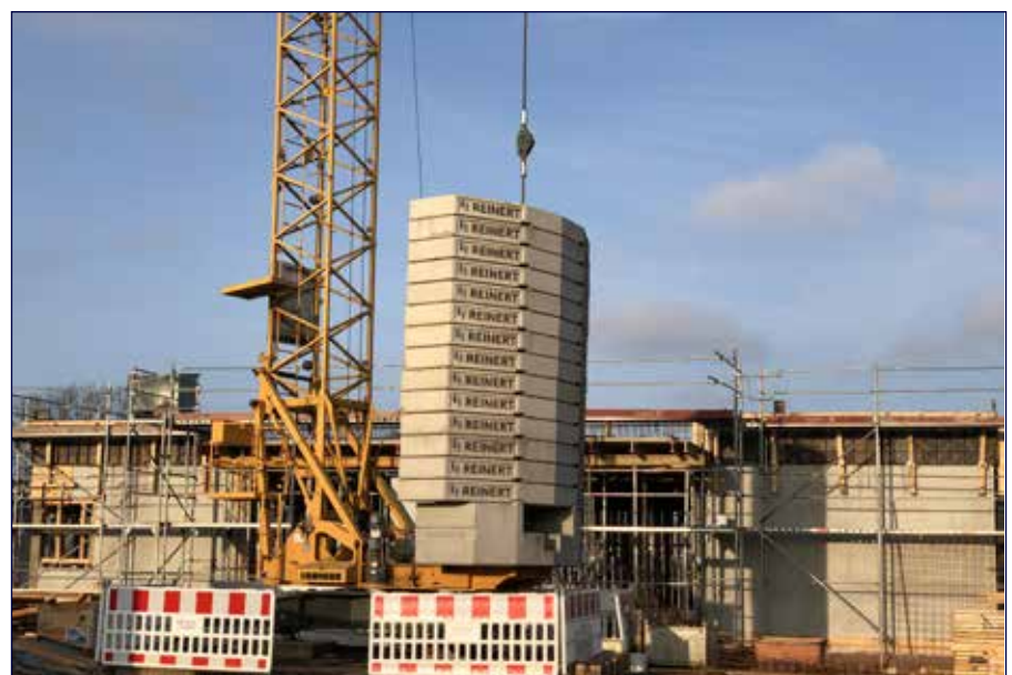
Neubau Pforte ZF Saarbrücken Foto: Kurt Josef Reinert GmbH
