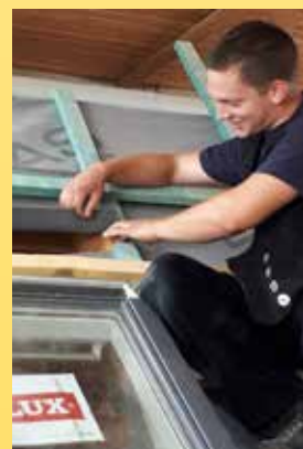
Velux Schulung für Zimmerer Azubis - Einbau von Dachfenstern 05.06.
