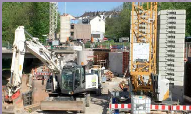
Bliesterrasse Neunkirchen Foto: OBG Gruppe GmbH
