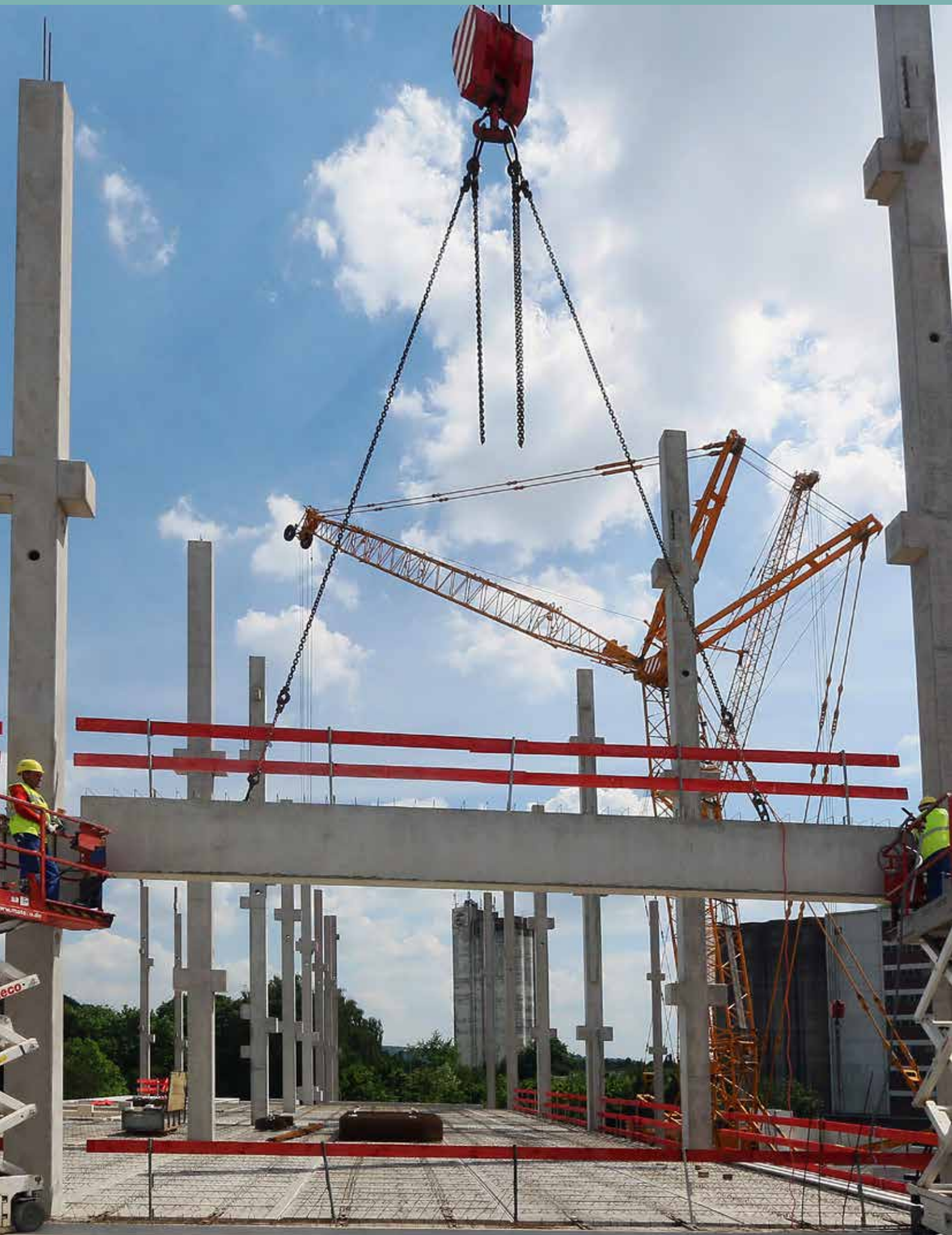
Neubau Möbel Martin, Saarbrücken Foto: Peter Gross Bau
