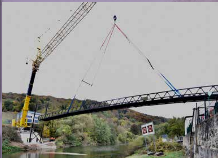
Metzdorf-Moersdorf Brücke Sauer Foto: Peter Keren Bauunternehmung GmbH
