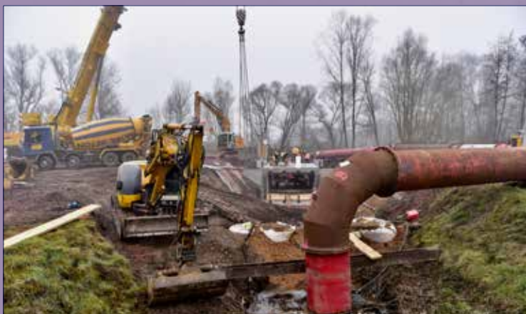
Bous EÜ Bommersbach Foto: Peter Keren Bauunternehmung GmbH
