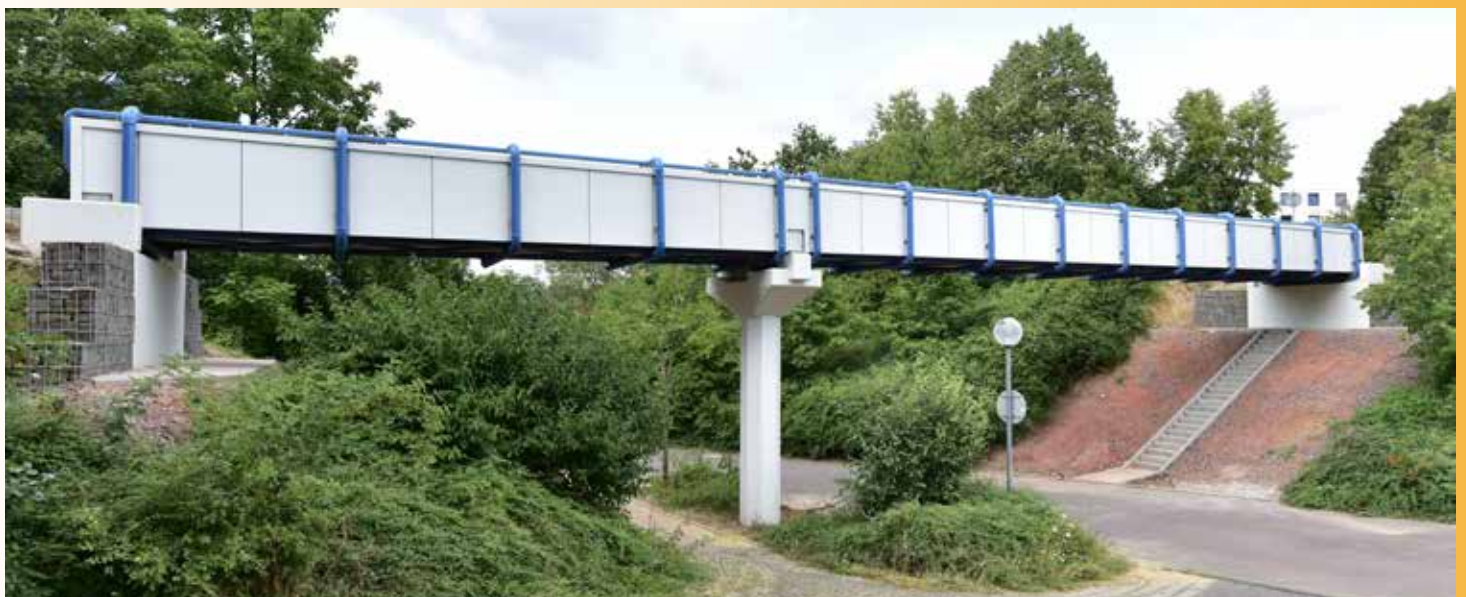
Brücke Universität Trier Foto: Peter Keren GmbH
