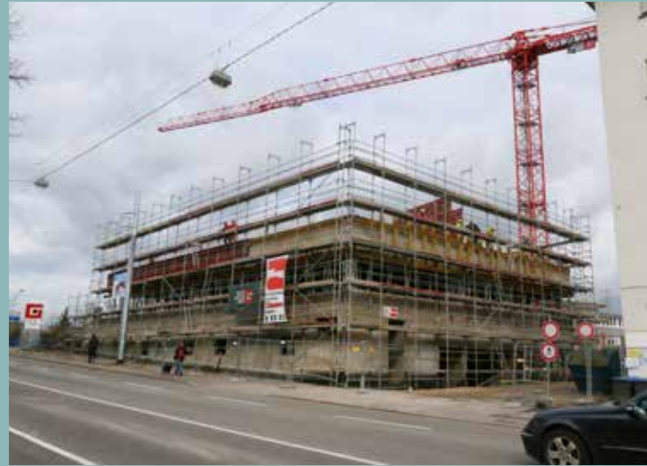
Neubau HTW Saarbrücken Fotos: Peter Gross Bau
